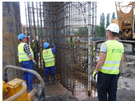
Rys. 1. Instalacja rury inklinometrycznej Figure 1. Installation of inclinometer casing
